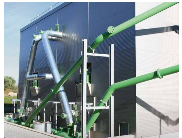
Austragssystem eines Kompogas®-Betonfermenters
